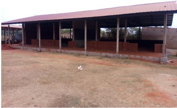
Bâtiment scolaire du collège d'Avéta
