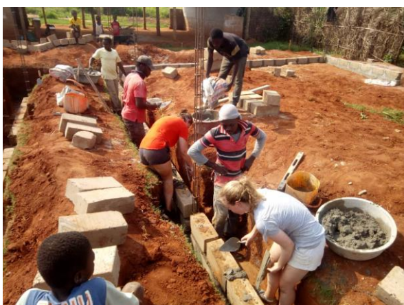
Camps-chantier à Avéta
